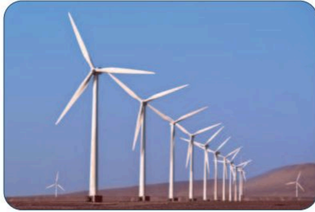
شكل 7-19 توليد الكهرباء باستخدام طاقة الرياح
