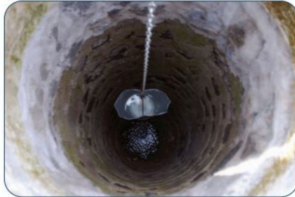
شكل 3-8 آبار المياه الجوفية
