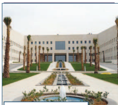
مبنى وزارة التعليم
