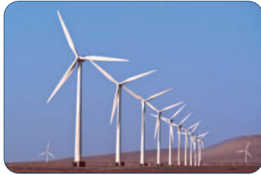
شكل 7-19 توليد الكهرباء باستخدام طاقة الرياح
