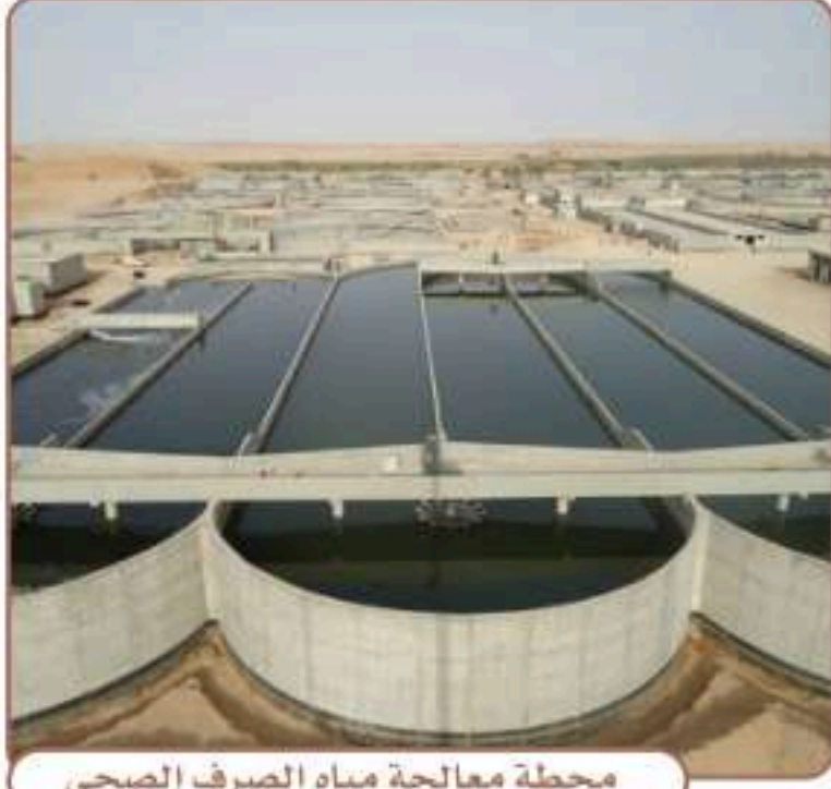
محطة معالجة مياه الصرف الصحي
