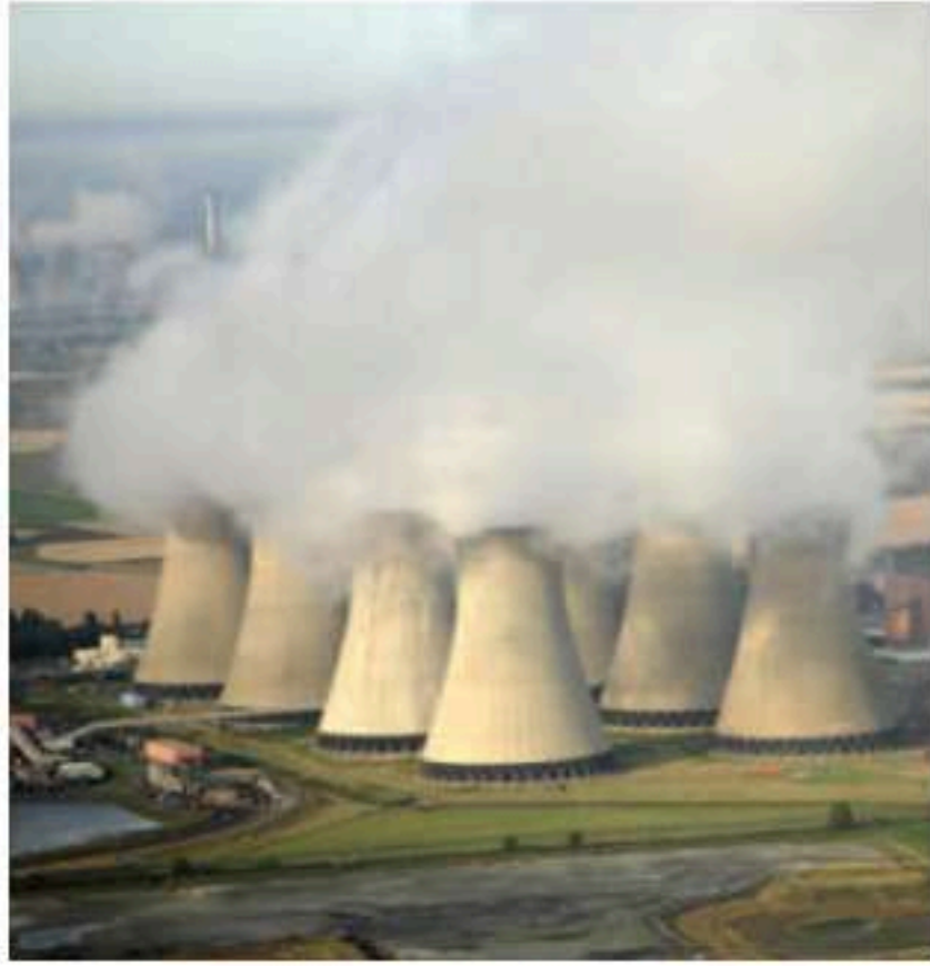
الشكل ٨ تستخدم محطة توليد الكهرباء أبراج التبريد لخفض درجة حرارة الماء الحار الناتج عنها.
