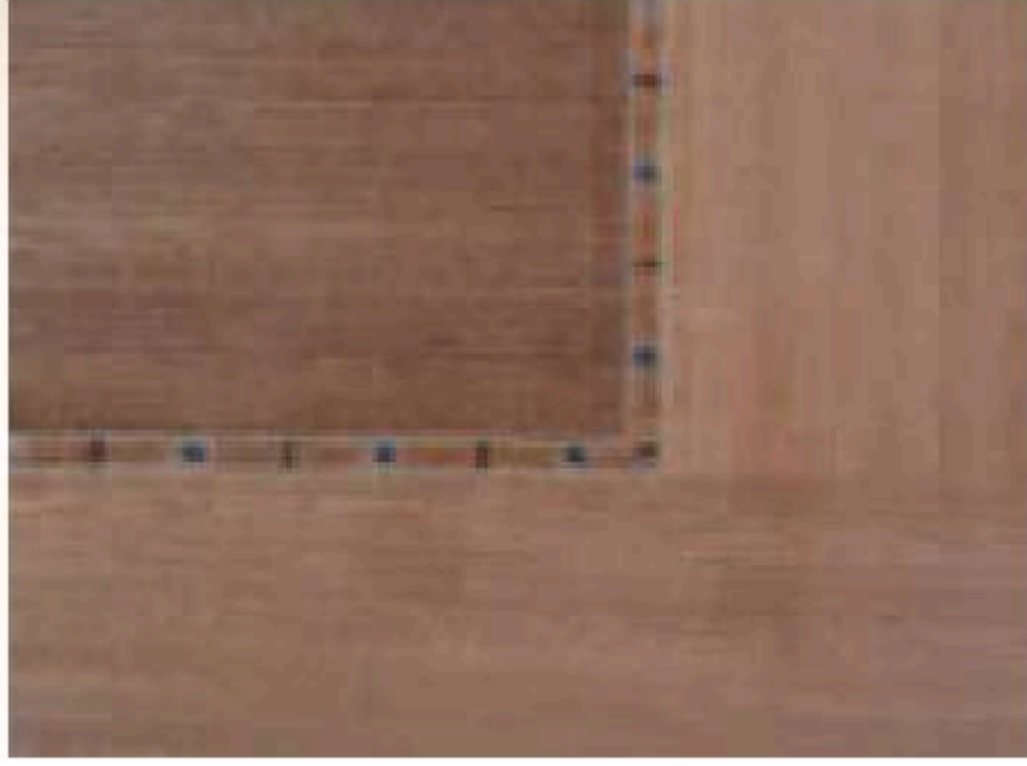
الشكل ( ٦٠ ) : تستخدم القشرة لتغطية الأسطح الخشبية على مساحات كبيرة .
